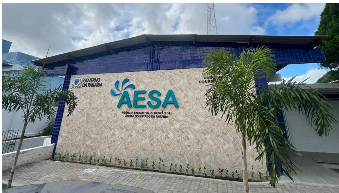
Figura 130 - Fachada reformada (novembro de 2023)
