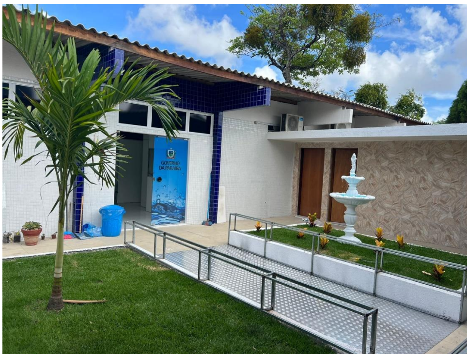
Figura 131 - Fachada interna reformada (novembro de 2023)
