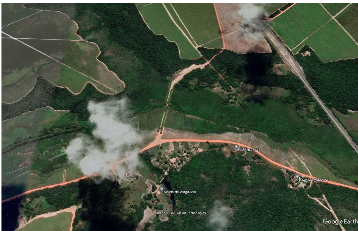
Figura 5-10 - Vista do local do barramento em 2020
