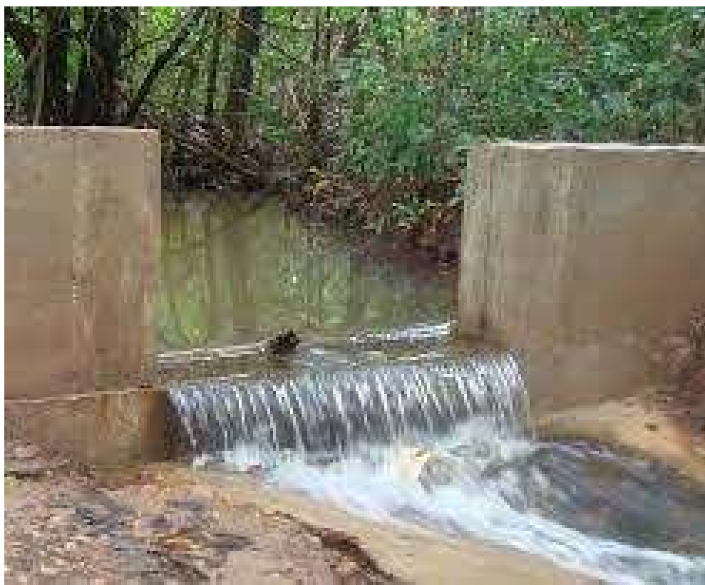
Figura 9-3 - Vertedor retangular em alvenaria.
