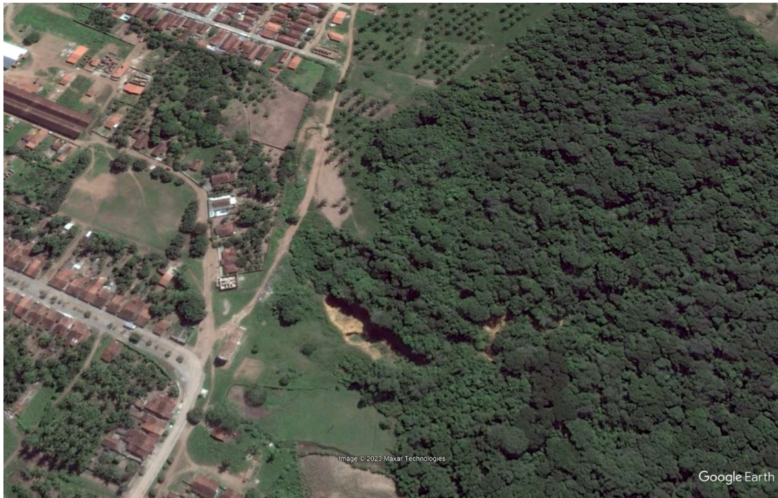
Figura 9-17 - Voçoroca junto à capela em imagem de 2015.
