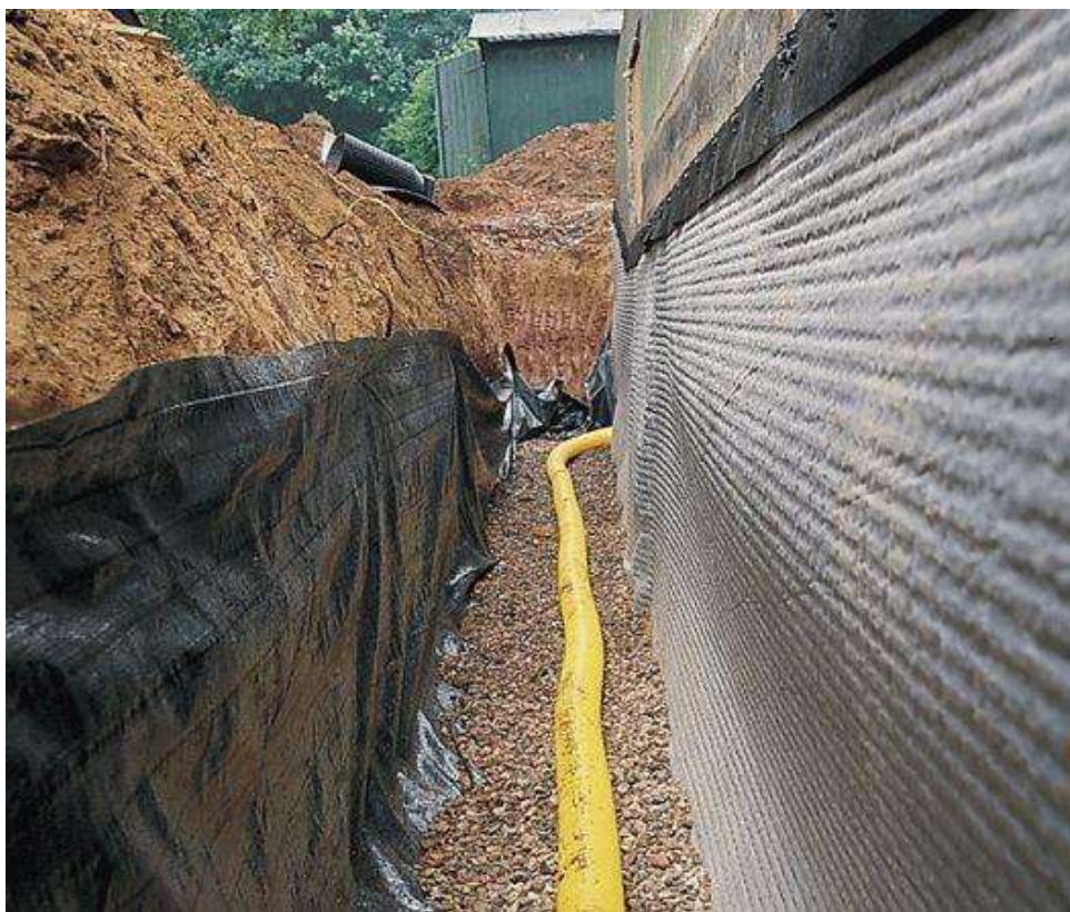
Figura 9-19 - Exemplo de trincheira drenante
