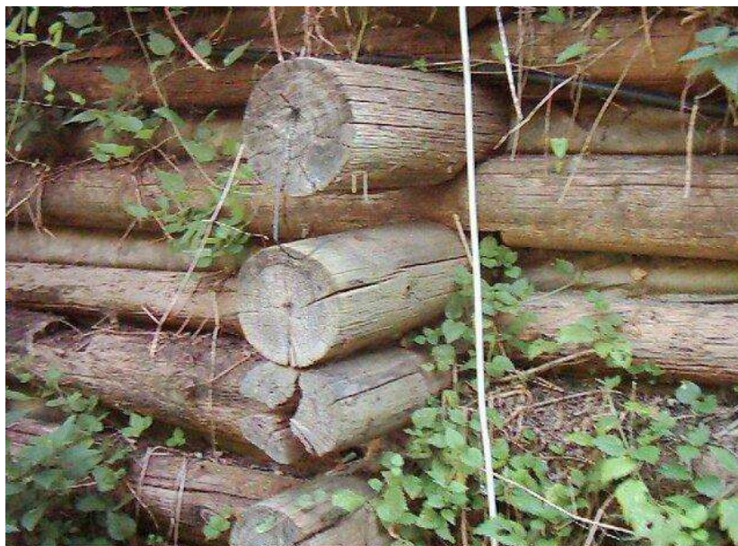
Figura 9-21 - Paliçada para recuperação da voçoroca
