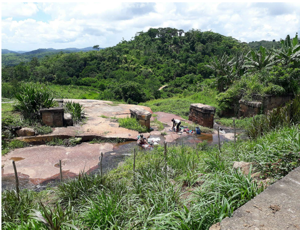
Figura 5-16 - Lajeado de granito em Borborema, antiga Usina hidrelétrica.
