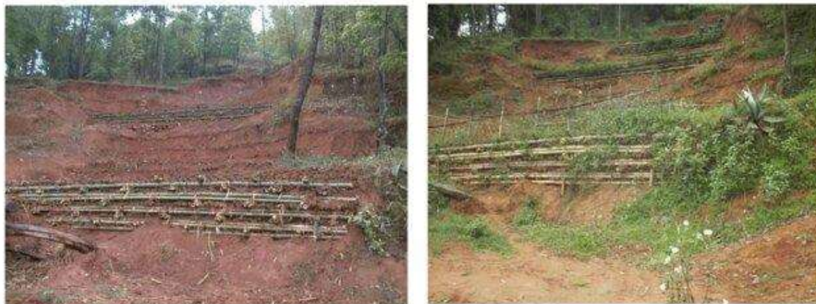
Figura 9-22 – Uso de bambu na recuperação Da Voçoroca
