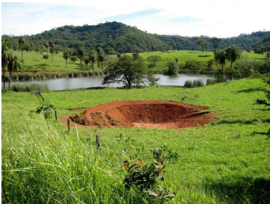
Figura 9-24 - Barraginhas de infiltração
