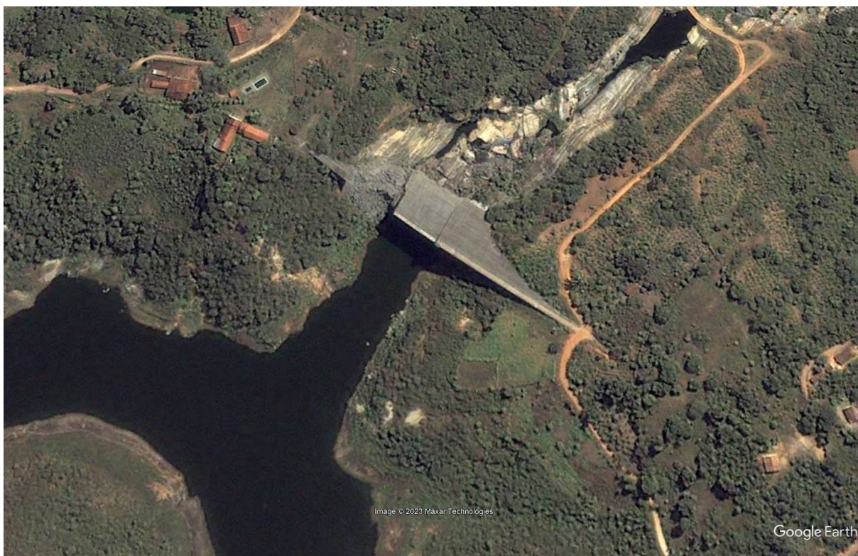
Figura 9-6 - Barragem Camará, em 2010.
