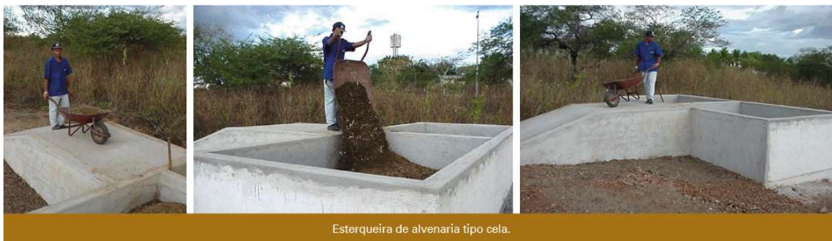
Figura 6-32 - Esterqueira tipo cela para caprinos e ovinos.
